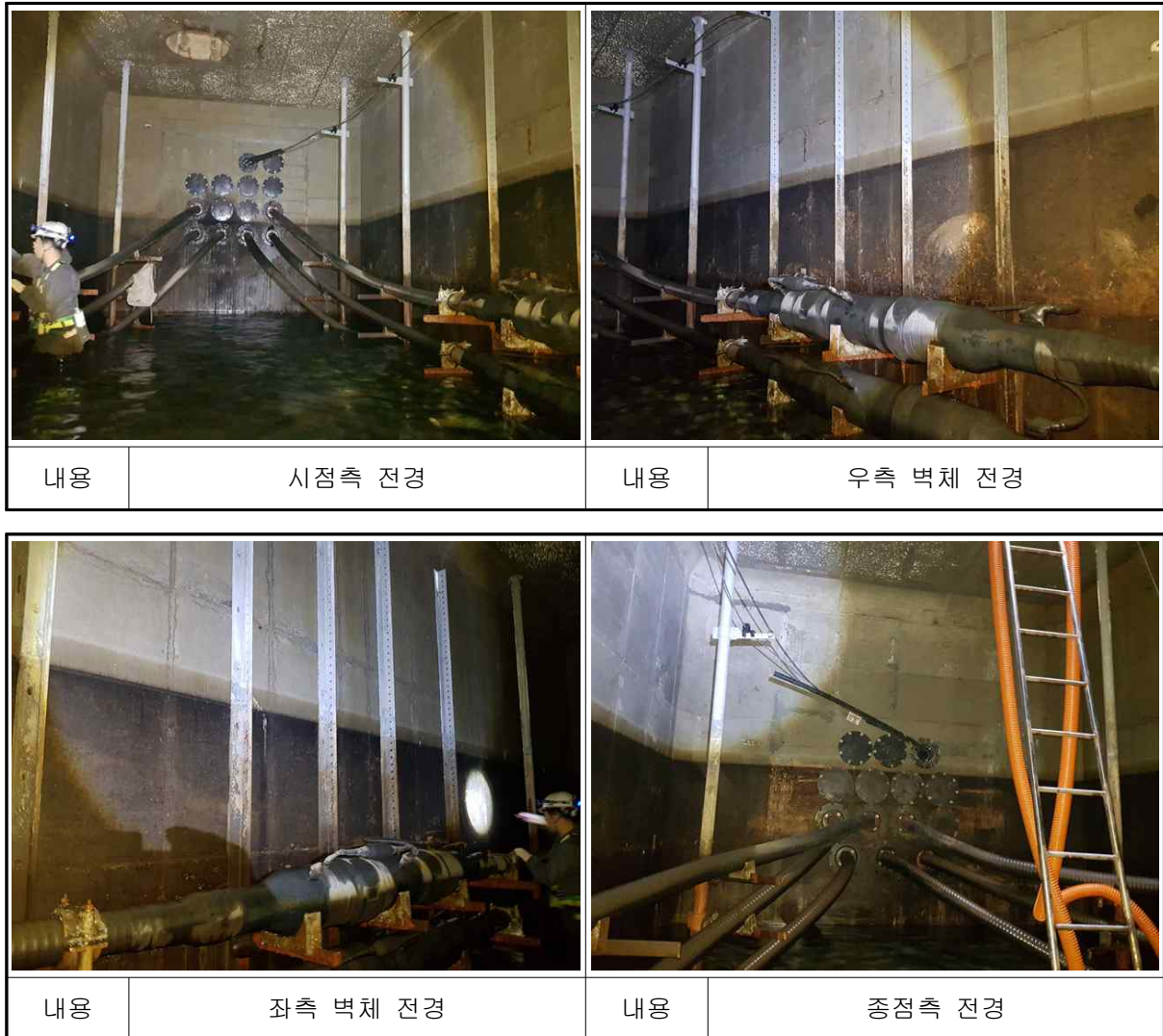
【사진 2.1】 문산~선유 #1 전경
