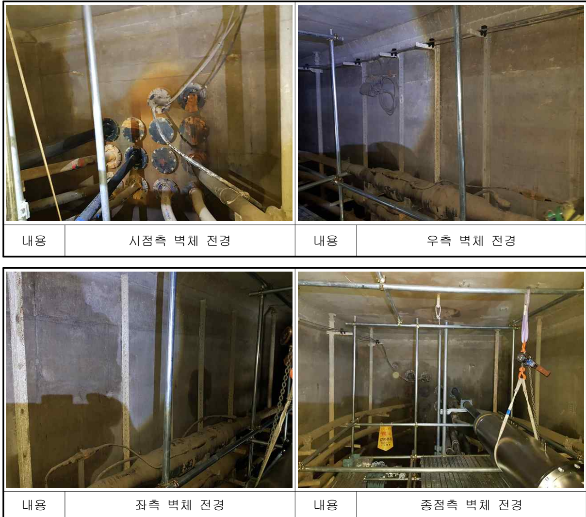
【사진 2.9】 문산~선유 #3 전경
